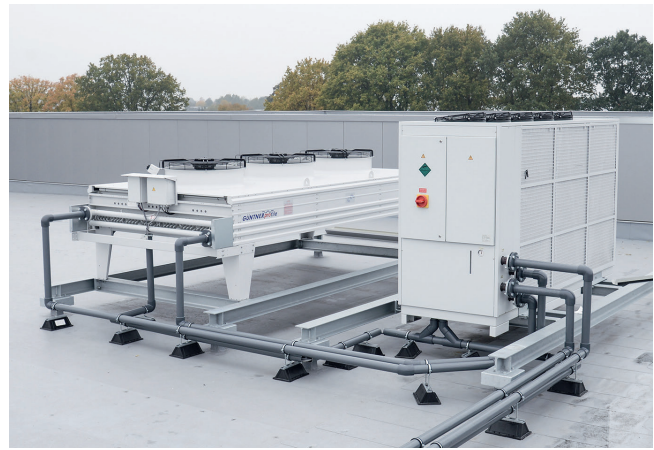
3 Die auf dem Dach platzierten Freikühler arbeiten bei bis zu 14 °C Außentemperatur mit 100 Prozent ihrer Leistung (© technotrans)
