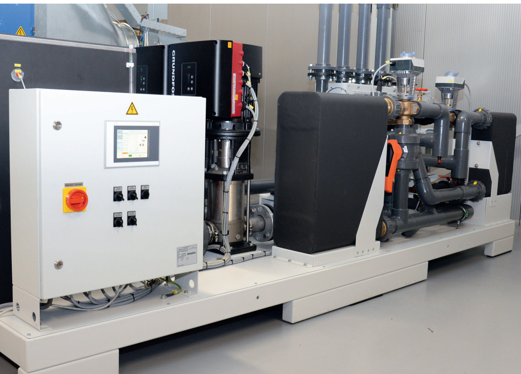
1 Der Zulieferer setzt auf ein zentrales Kühlsystem mit einer Leistung von 130 kW. Zwei redundante Pumpen sichern im Fall einer Störung den weiteren Betrieb ab (© technotrans)
